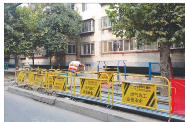
与幸福小区只有一墙之隔的黄桥小区正在进行燃气改造。
