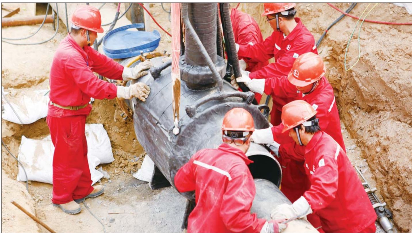
施工人员正在认真地安装组对焊口。
