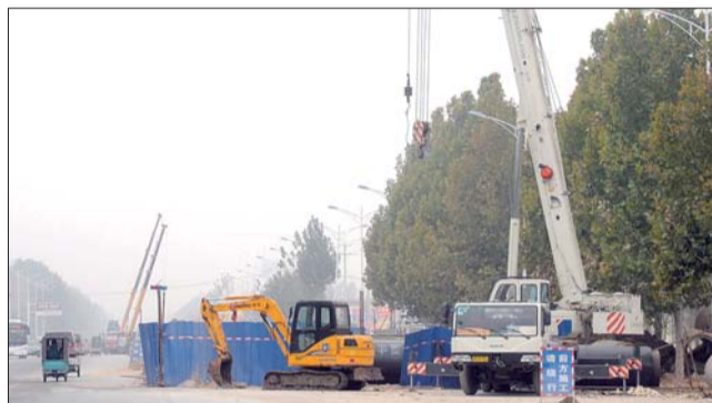
本报记者探访供热管道铺设现场。 本报记者 邓兴宇 摄
