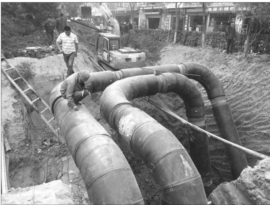
建设路上供暖管网正在建设当中。本报记者 张召旭 摄
