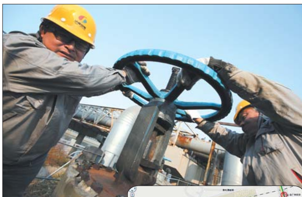
▲北郊热电厂,工作人员正在缓慢打开阀门,送蒸汽暖管。 本报记者 蒋龙龙 摄
