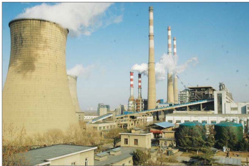
齐鲁石化热电厂生产厂区。
