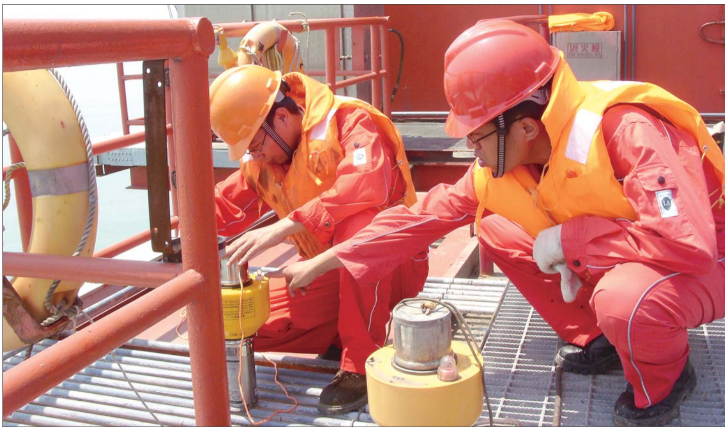
管理区职工对平台设施进行检修。(通讯员 提供)
