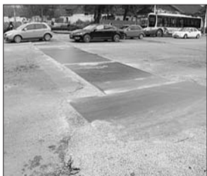
已经铺上铁板。
