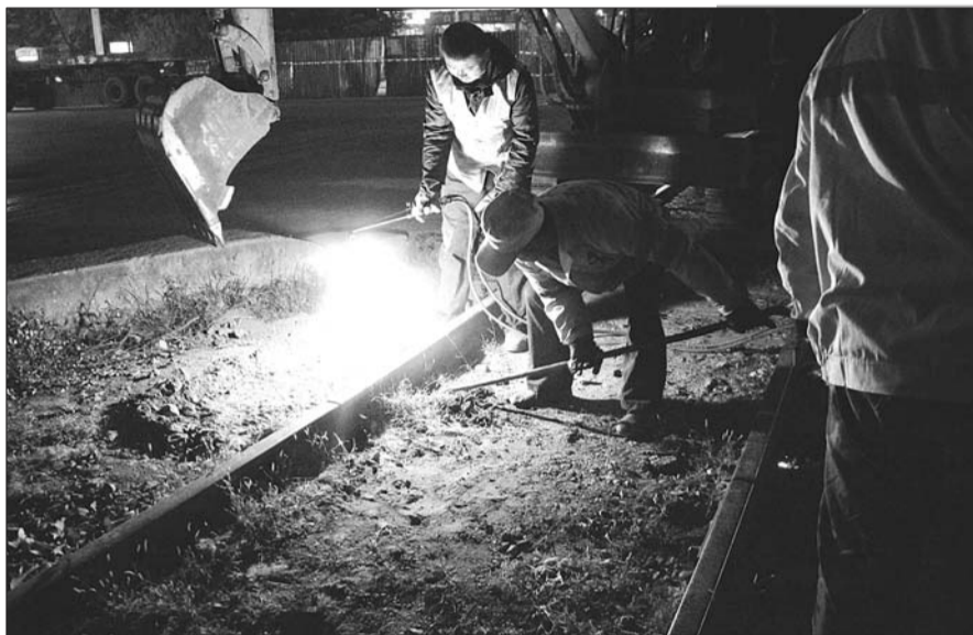
拆除铁路岔子。
