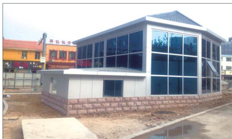
滤站内超滤设备已在试运行。
