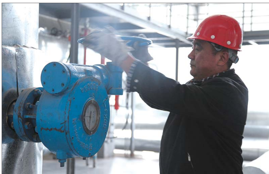
热力公司工作人员正在对章丘余热的管网进行调试,保证高新区供暖。 本报记者 蒋龙龙 摄
