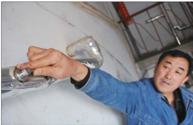
维修工孙迎彩检查楼道阀门。
