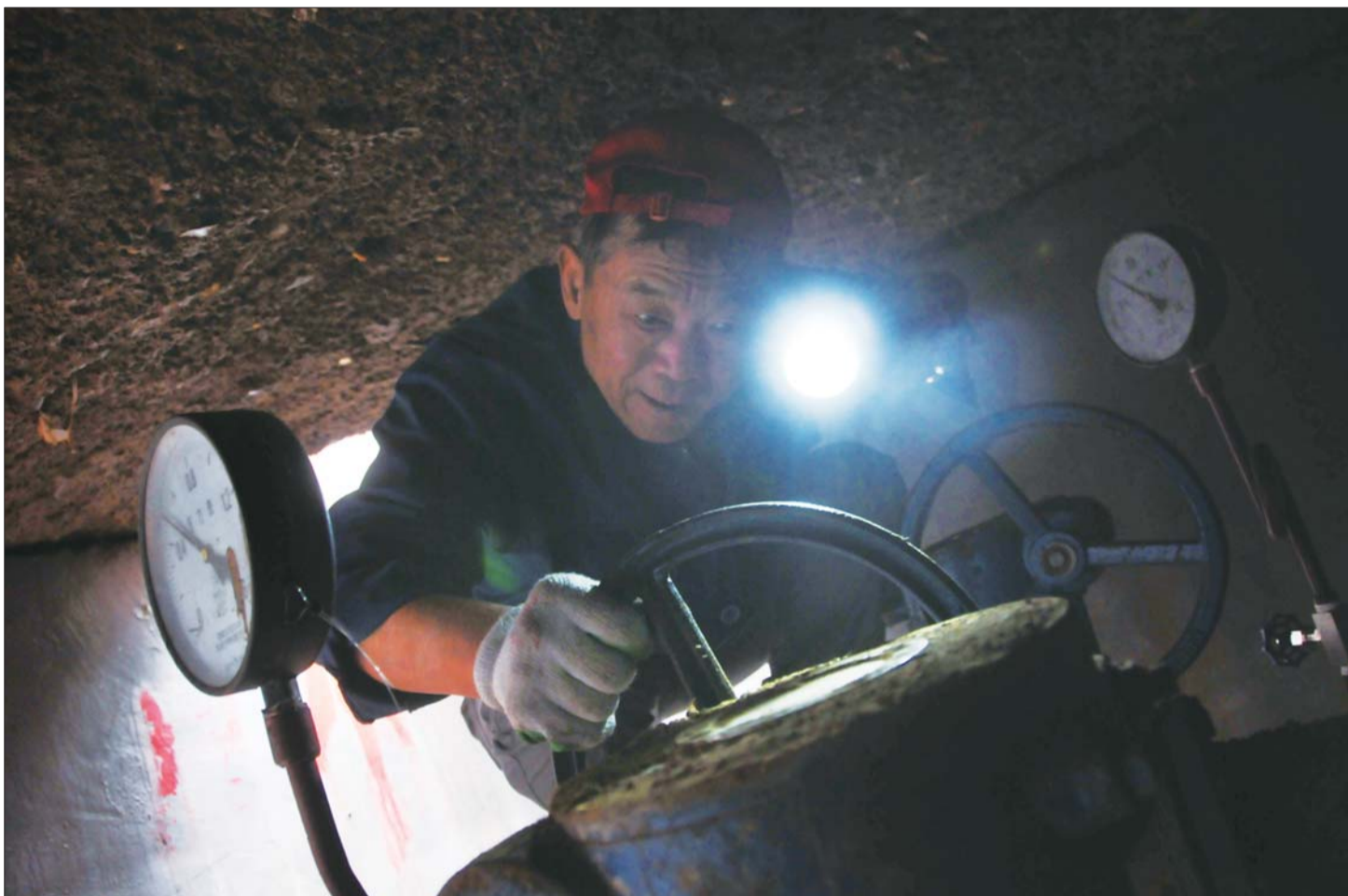
◀ 维修工赵学良到井下开阀门,对井下黑暗、潮湿的环境早已习以为常。
