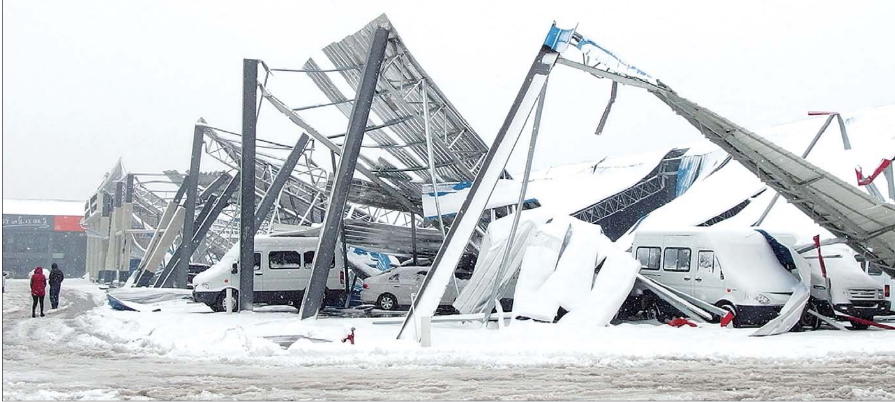
24日凌晨,位于临沂市区西部的一家二手车市场钢结构顶棚坍塌,数百辆车被压在下面。本报记者 高祥 摄
