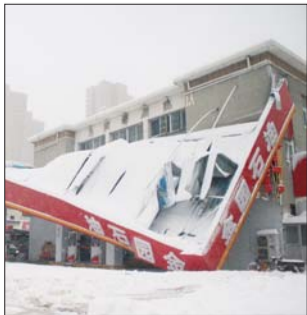
24日,风雪过后,菏泽人民路与中山路交叉口附近的一家民营加油站顶棚塌了。本报记者 袁文卿 摄
