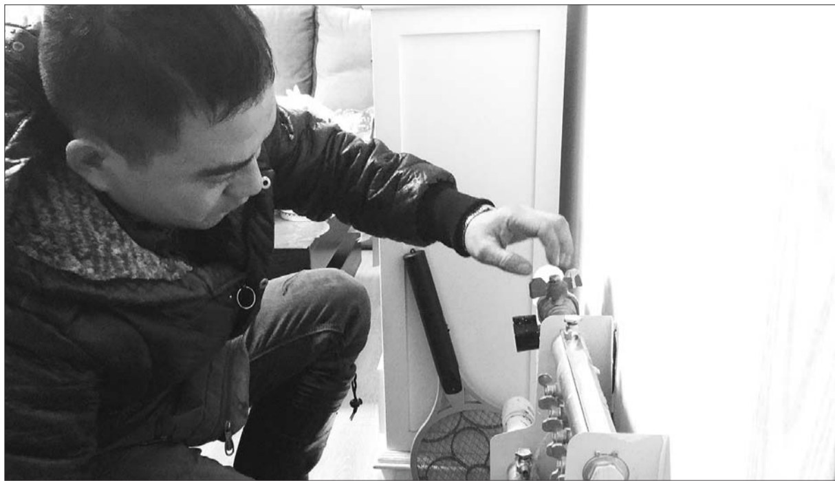
工作人员正在修理暖气。本报记者 李岩松 摄
