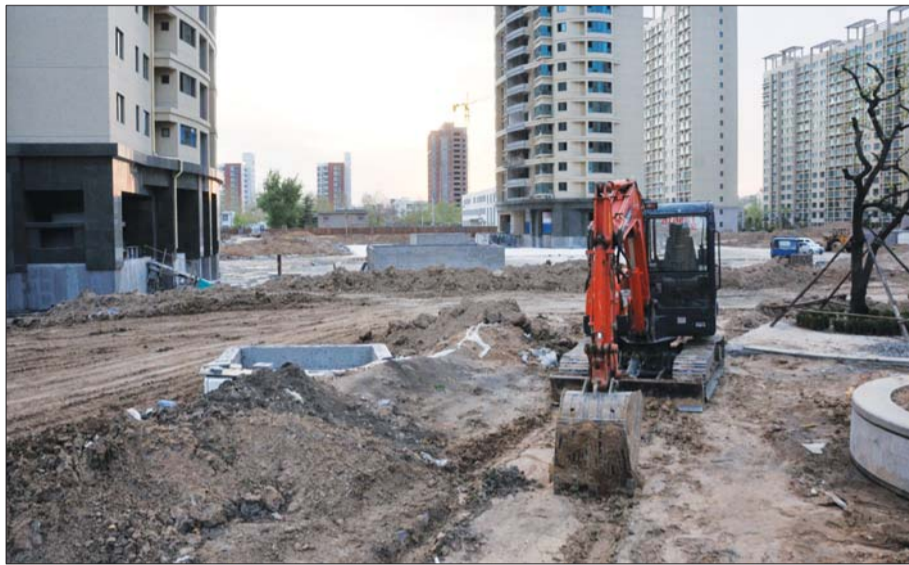
施工现场应实行封闭管理,抑制扬尘(资料片)。
