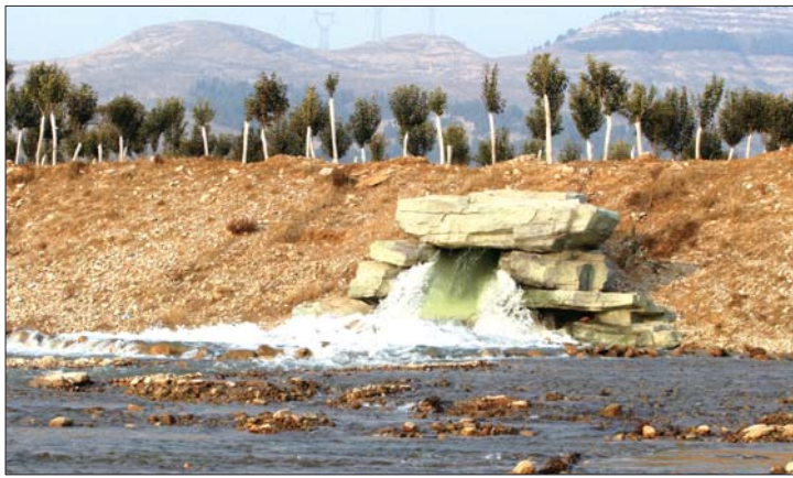
来自济平干渠的黄河水和长江水正在被调向卧虎山水库。 记者 蒋龙龙 摄
