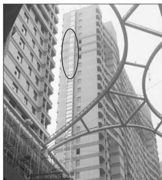
这栋住宅楼外墙正在建烟囱。
