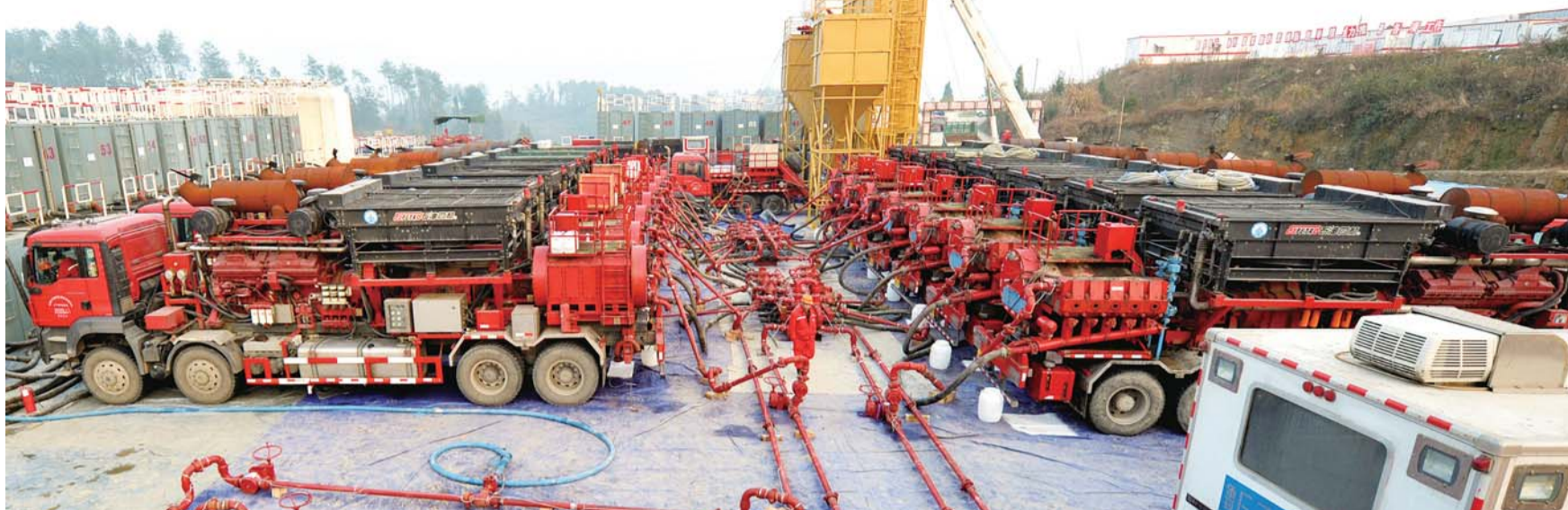
重庆涪陵页岩气压裂施工现场。
