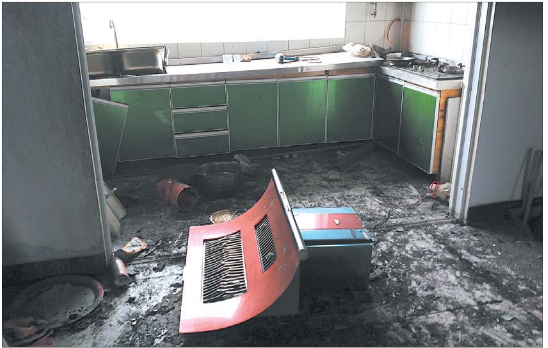
厨房内的吸油烟机被炸至客厅。
