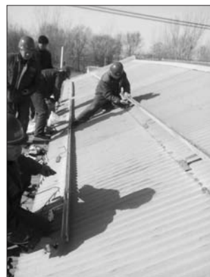
施工人员正在架设发电设备。 记者 李军 摄
