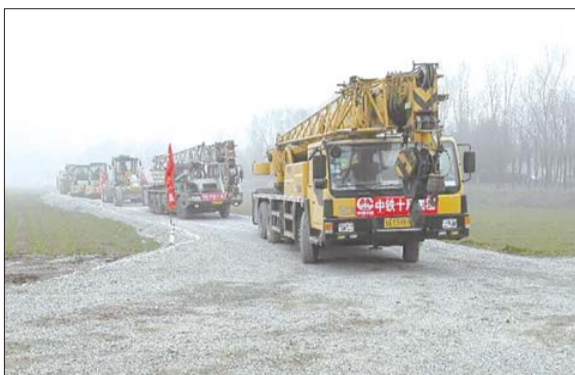
24日上午,施工车辆开进现场。
