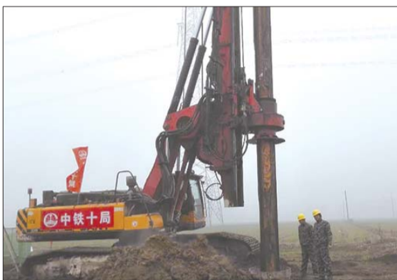
24日上午10时,济青高铁第一桩开钻。
