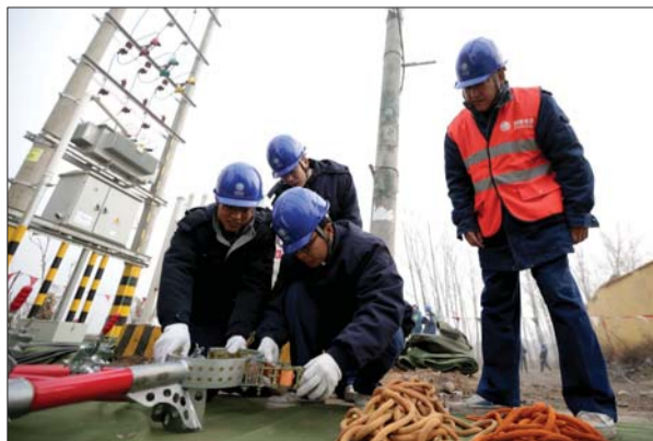
工作人员正在进行检修作业。
