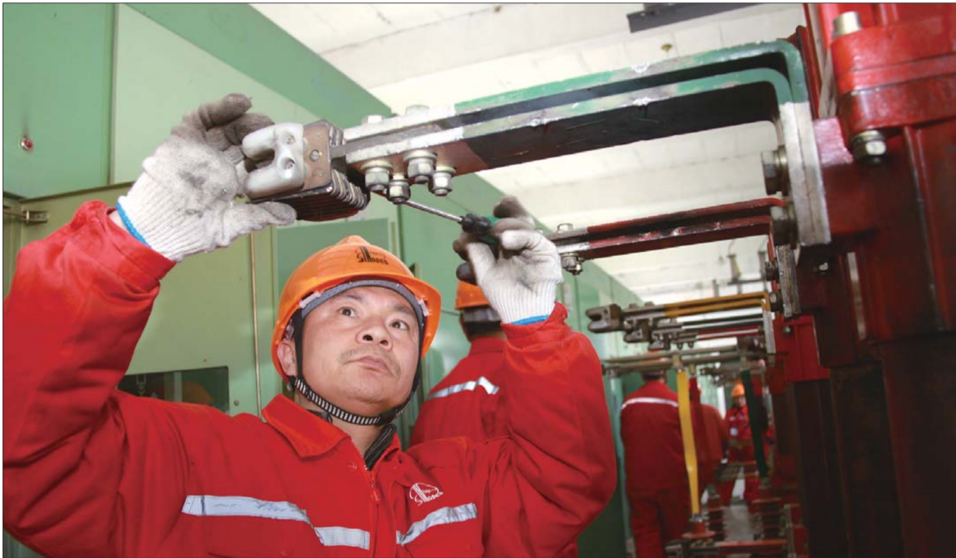
修试中心职工柯峰在对35kv永三变少油开关接头进行紧固。
