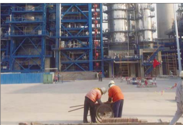
齐鲁石化生产厂区。
