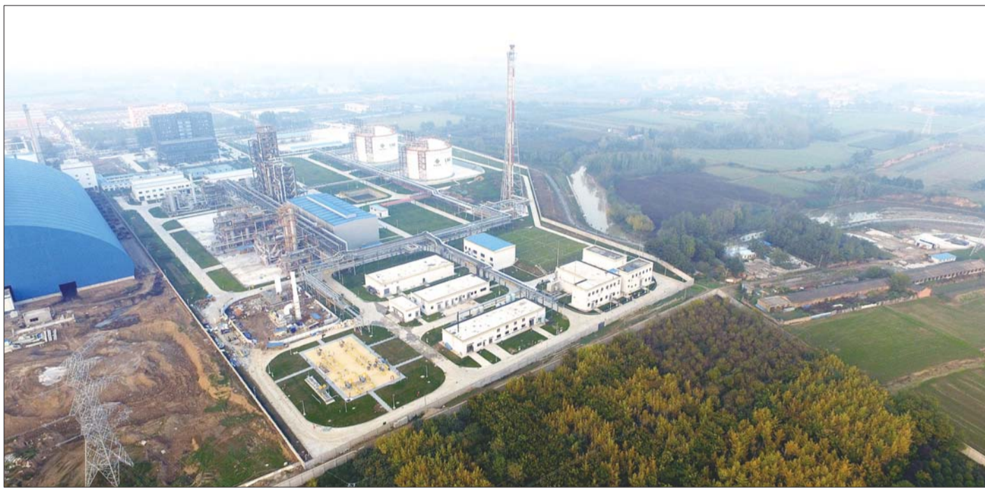
陕西首个LNG应急储备调峰项目全景图。
