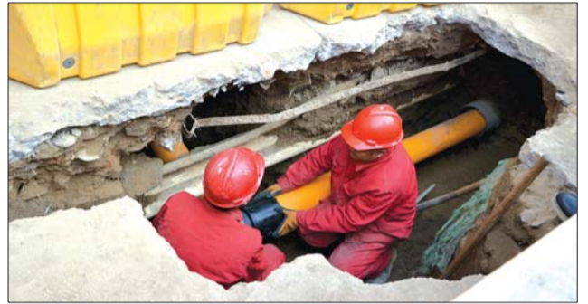
工人们改造燃气管道。本报记者 王世腾 摄
