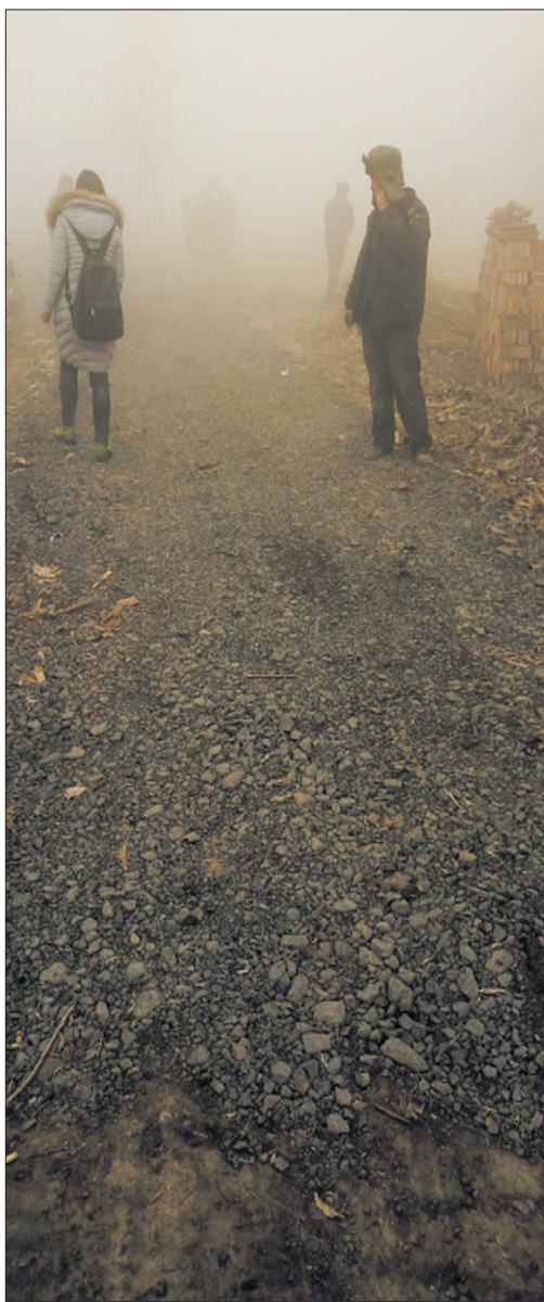
通往彩椒大棚的道路上,有一段已经铺设了煤矸石。
