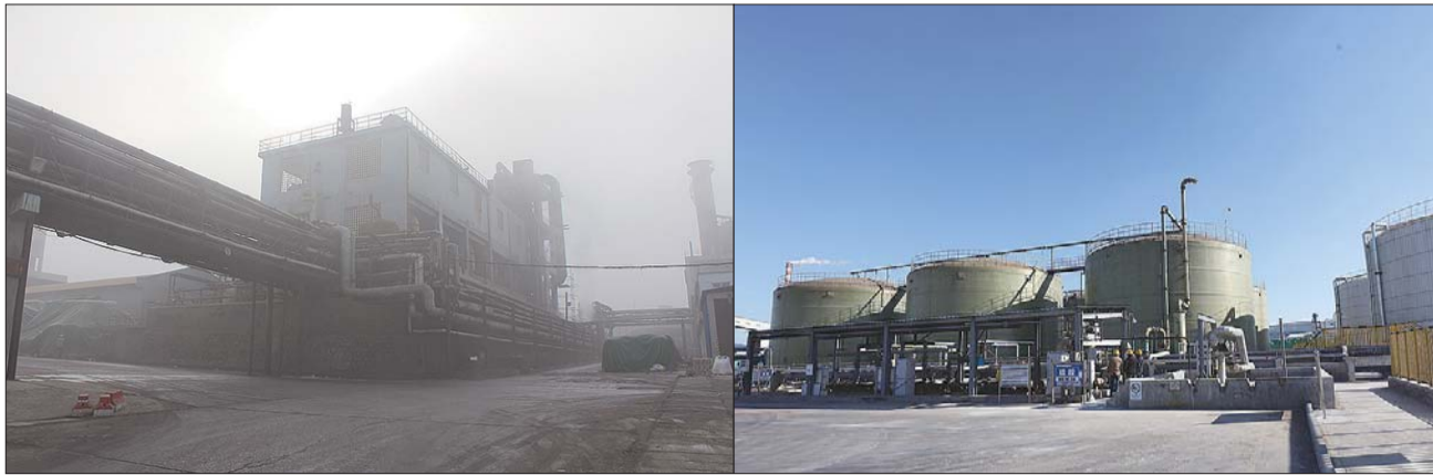
2015年12月31日,青岛碱业位于老城区的老厂,设备比较陈旧。
