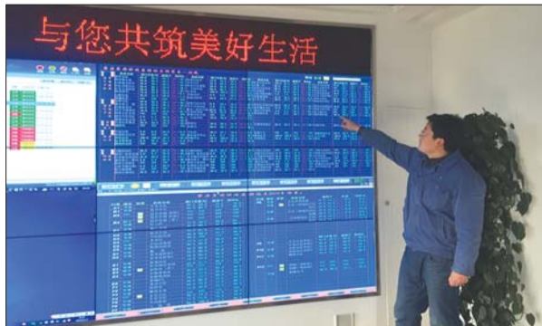
工作人员介绍小区换热站的供热参数。本报记者 庄子帆 摄
