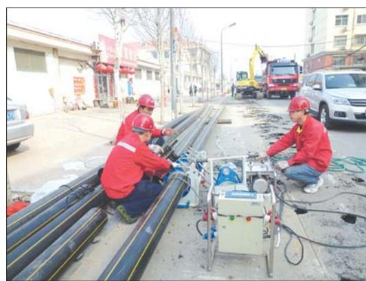
对新更换的PE管道进行焊接。
