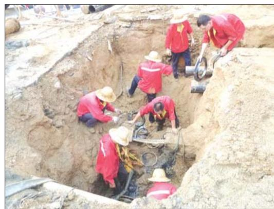
施工人员对地下管道置换接口。
