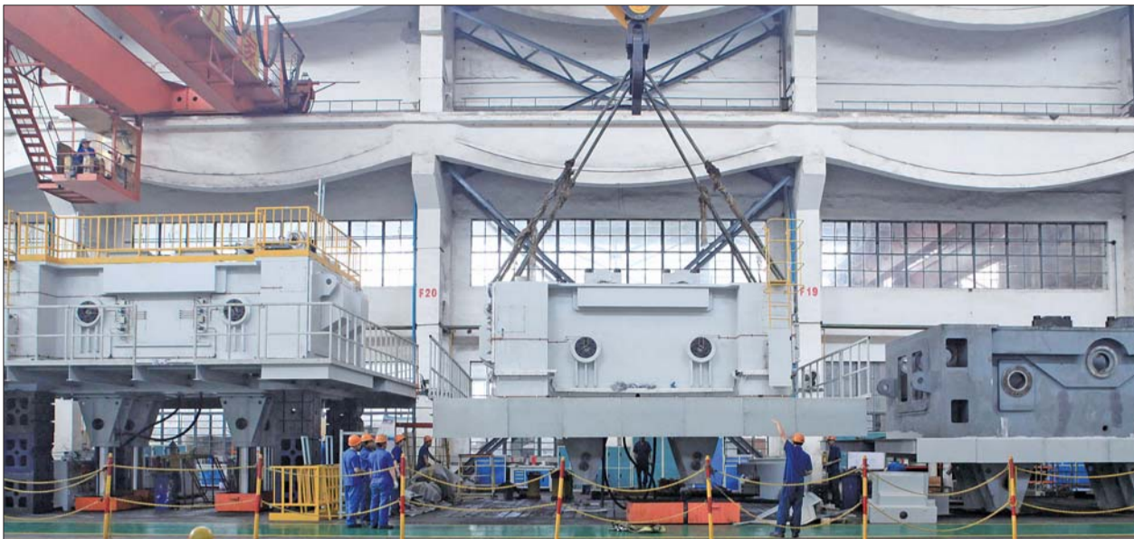
济南二机床吊装现场。受访者供图
