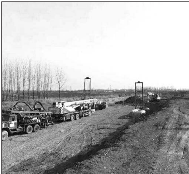
济徐高速公路金乡连接线工程正进行路基施工。
