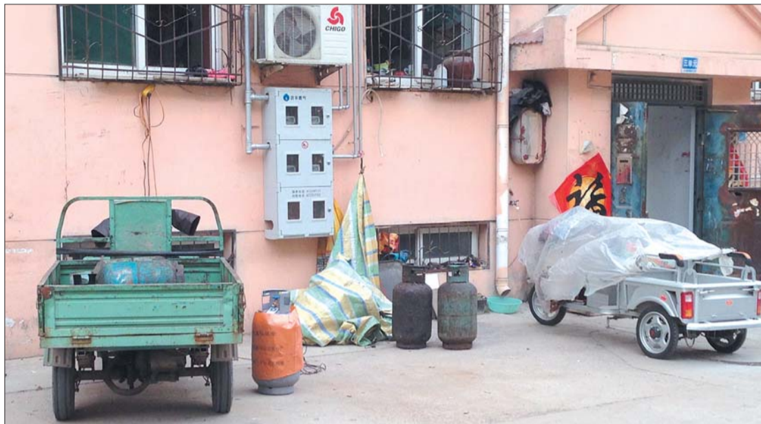
小区居民楼楼道外随意放置着几个液化气罐。
