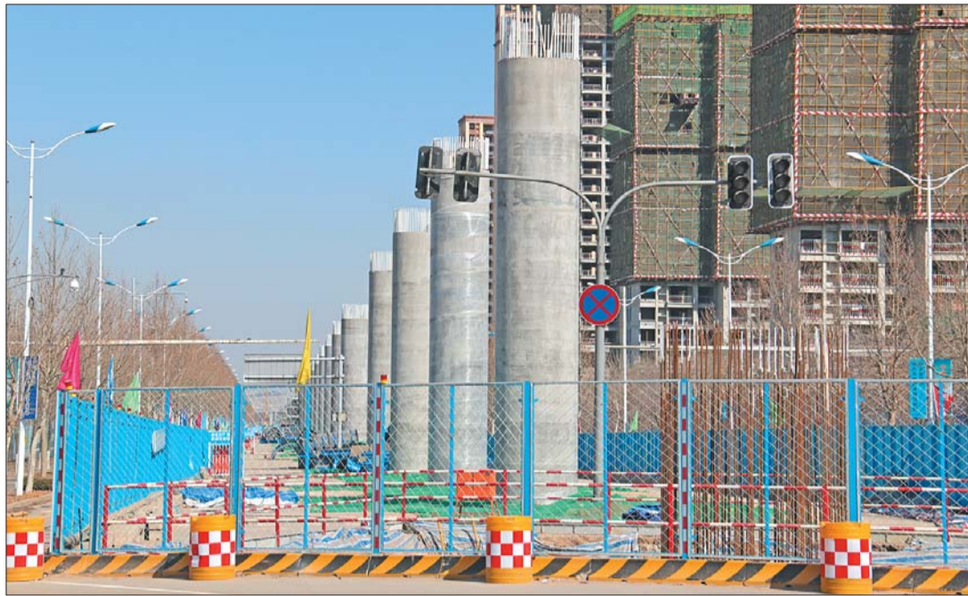
轨道交通R1线试验段施工现场。
