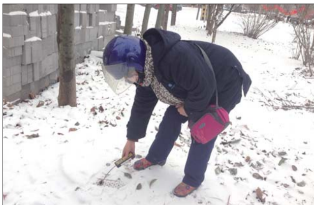
巡线员正在冒雪检测排查市政井室。(资料片)
