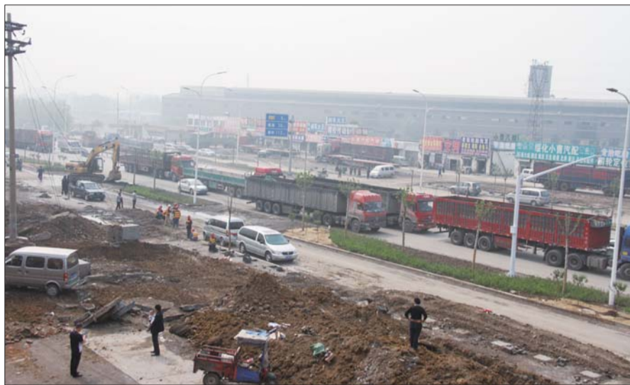
张店郊区一条道路的路旁,原垃圾堆成的小山,目前已基本清理。本报见习记者 李洋 摄
