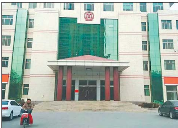
高青县民政局原来的办公楼已腾空,正在装修改造。
