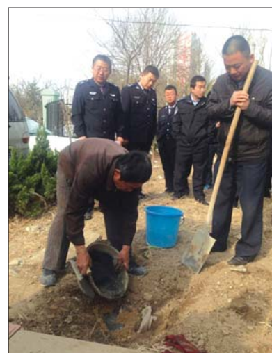
工人们正在封填自备井。
