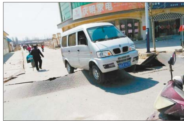
路面拱起,一辆面包车被顶了起来。 读者供图
