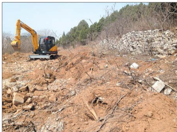
金鸡岭南边山脚挖掘机在施工。 本报记者 王皇 摄
