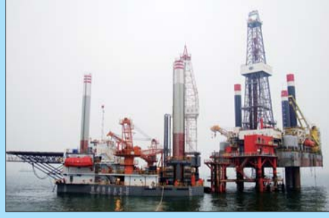
作业平台正在准备施工。 本报通讯员 丁剑北 摄
