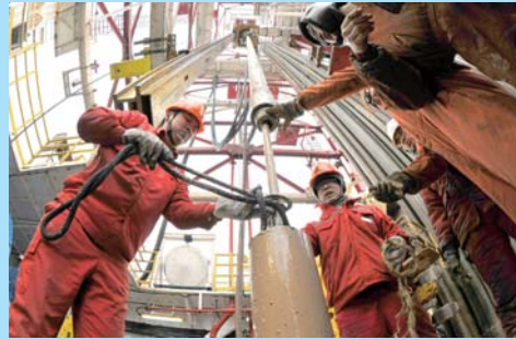
新胜利一号平台进行完井作业施工。本报通讯员 王为 摄
