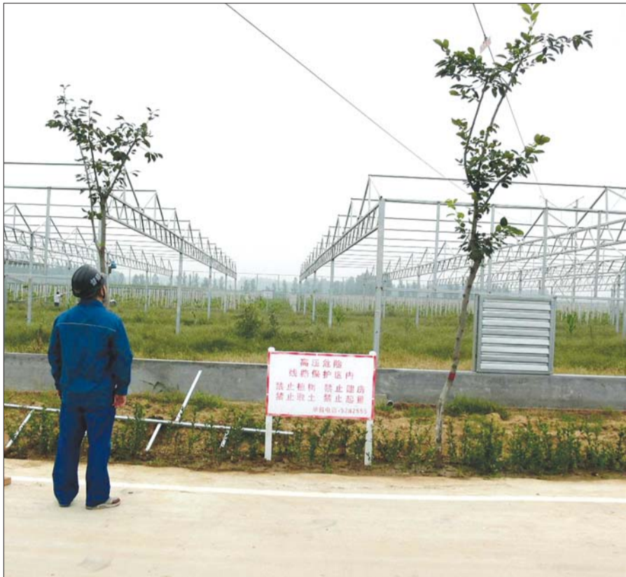
输电线路防护通道内,棚架已全部拆除。
