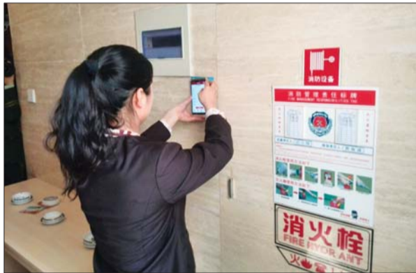
酒店巡查人员用“智慧消防安全服务云平台”检查消防设施。本报记者 柳斌 摄
