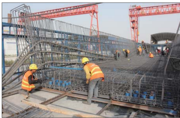
济青高铁施工进度顺利。 本报见习记者 李洋 摄
