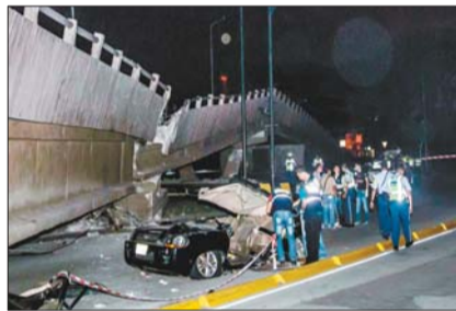
16日，在厄瓜多尔瓜亚基尔，高架桥在地震中坍塌，压扁一辆小轿车。新华社发
