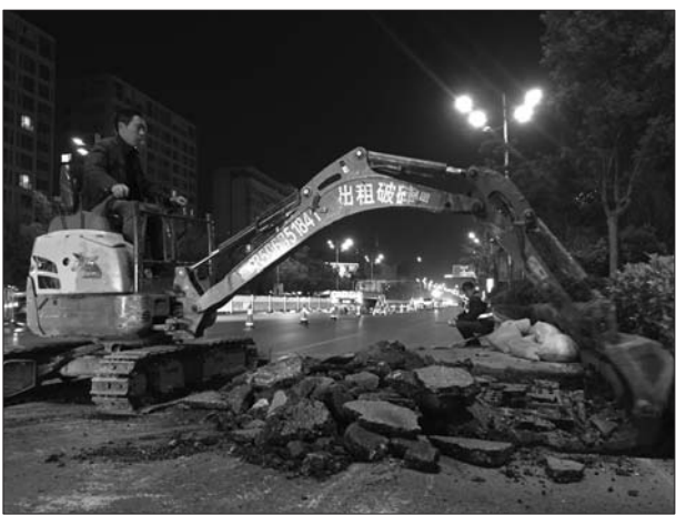
施工人员正在对检查井四周进行加固改造。本报记者 张召旭 摄
