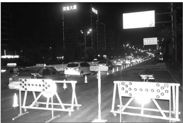
东昌路夜间开始半封闭施工。 本报记者 张召旭 摄
