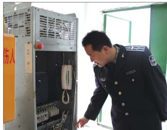
检查电梯机房。
