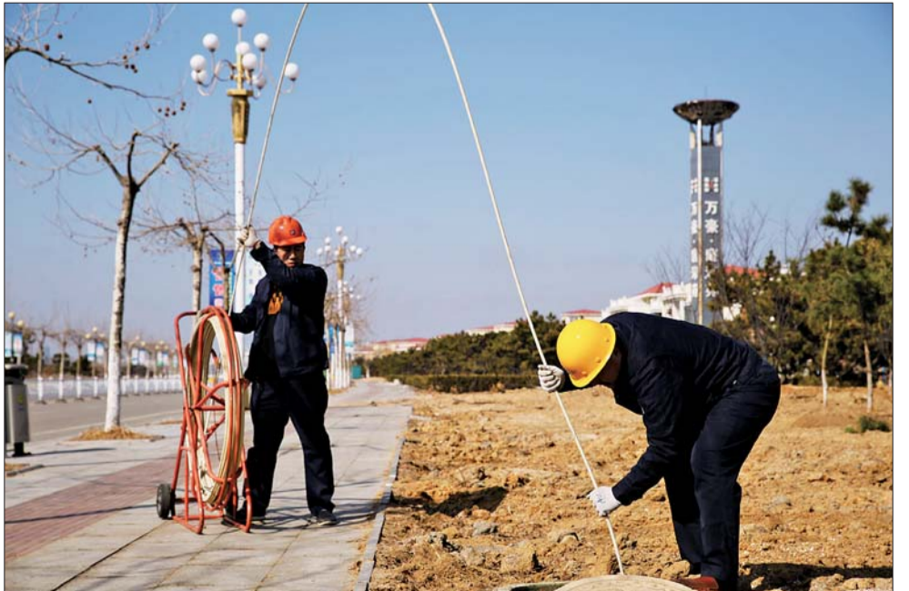
乳山银滩广电公司的服务人员在安装光纤网络。
