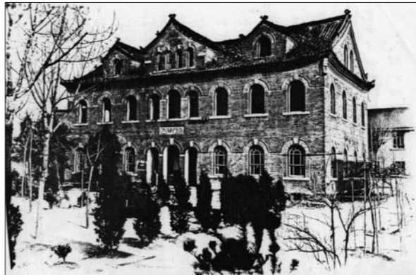
德门医院病房楼。
