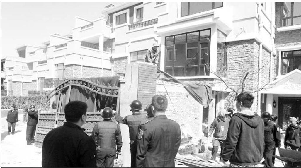
济南某小区,城管执法人员在拆除违章建筑。在目前的基层执法中常常有不少临时工参与其中。(资料片)
