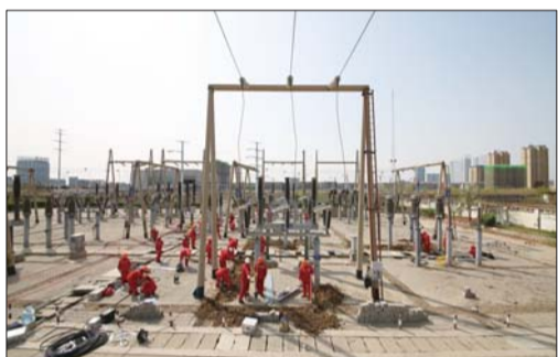
职工在变电站进行电网检修改造。
