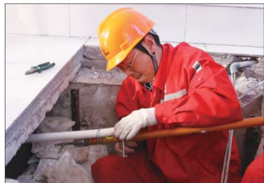
职工钻进电缆沟绑扎工具以便拖拽电缆。
