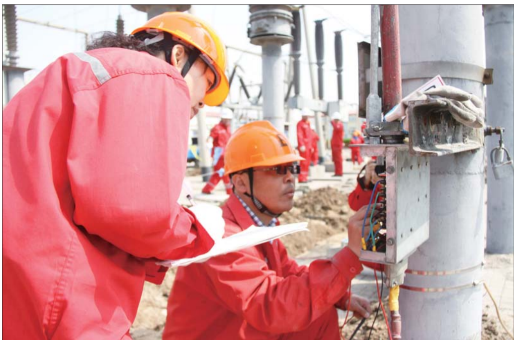
职工正在认真检查接线端子。
