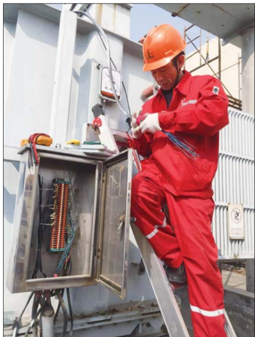
职工正在进行主变温度计更换及相关二次接线处理工作。
