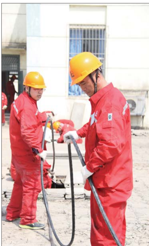
检修人员在现场下放电缆。
